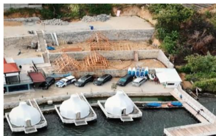
Gambar 1. Kondisi Proses Pembangunan Glamping Sumber : Tiktok @onion.glamping.al
