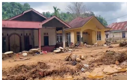
Gambar 1. Kondisi rumah warga yang terkena dampak Banjir Bandang
